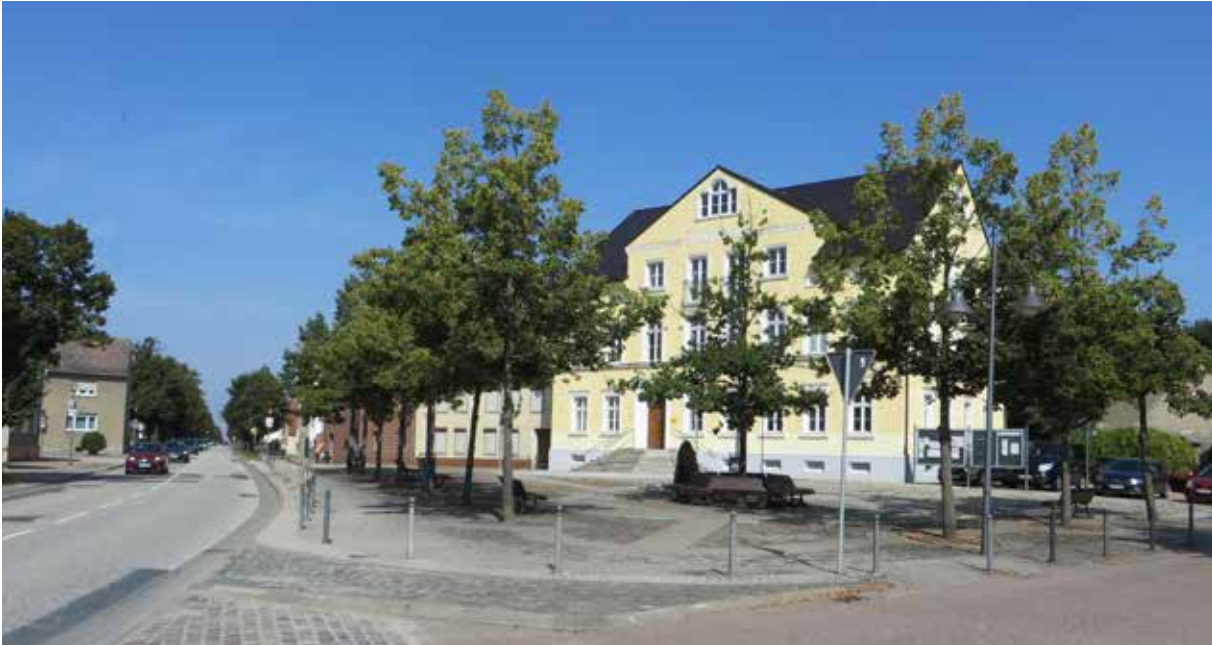
Abb. Blick auf das ehemalige Rathaus in der Ortsmitte
