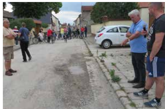
Abb. Sanierungsbedürftige Straße in Atzendorf
