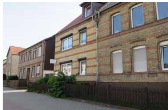
Abb. Bergarbeitersiedlung nördlich der Löderburger Straße
