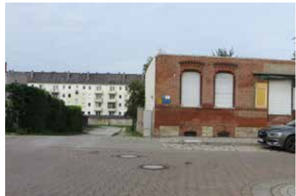
Abb. Blick auf Baubrache in Gänsefurter Straße
