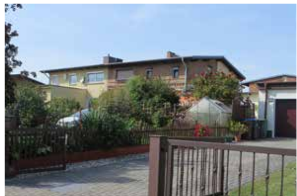
Abb. Historischer Werkwohnungsbau mit Kreuzgrundriss
