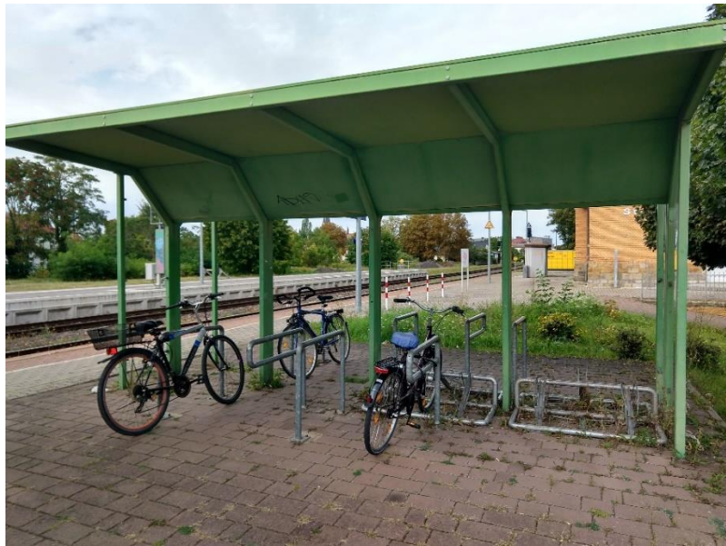
Abbildung 13 überdachte Fahrradbügel am Bahnhof Staßfurt Ostseite (ISUP 21.09.2023)
